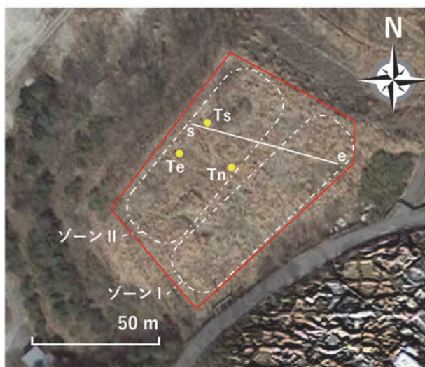
図 1 対象処分場の全景、観測孔位置及び比抵抗測線。(Ts, Te, Tn: 観測孔位置・名称, s 及び e: 比抵抗探査測線始点(0 m)及び終点(70.5 m)).
