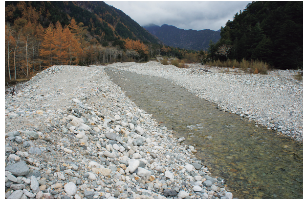
図2 上高地奥又白谷出合上流の仮設橋近くの河岸につくられた、掻き上げ堤防(2018年10月29日撮影)。
