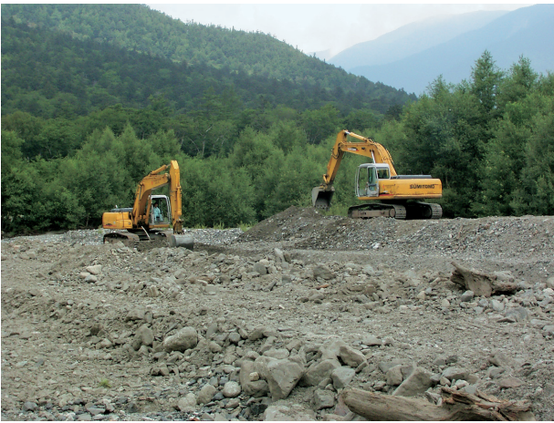
図1 上高地梓川支流黒沢での河床の砂礫の除去の状況(2005年8月4日撮影)。
