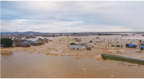
図5 鬼怒川の破堤氾濫。(国土地理院 Web サイト 3) )
