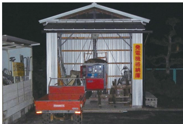
図14 丸亀市川西地区にある大型発電機格納庫。
