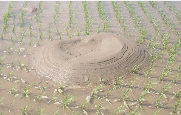
図6 矢部川で見られた堤内地の噴砂。(国土交通省提供)
