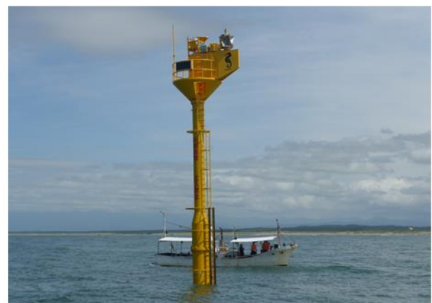
写真 2: 山形県庄内沖に設置した洋上風況観測システム 1 号機
