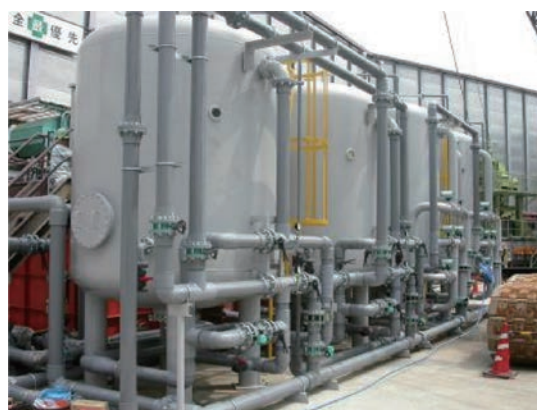
図7 川西市・洪水調節池建設工事湧水処理。
